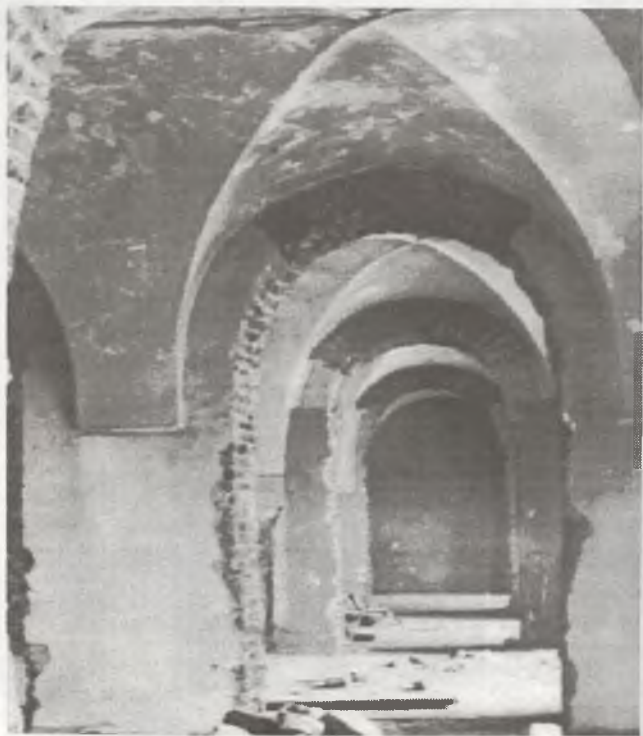
A múzeum épületének emeleti szárnya a helyreállítás alatt, 1959.
