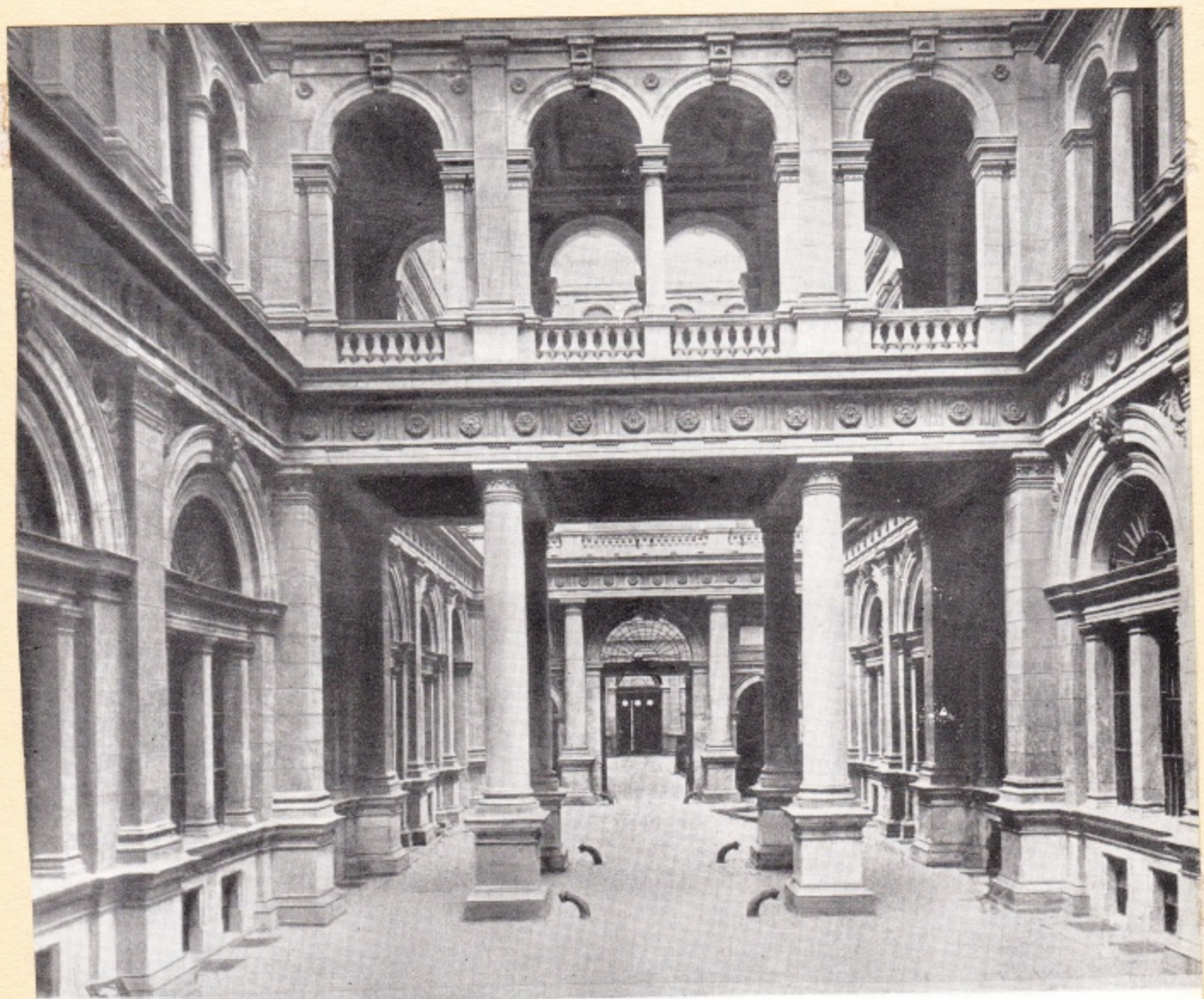
123. A Vámház udvarai
